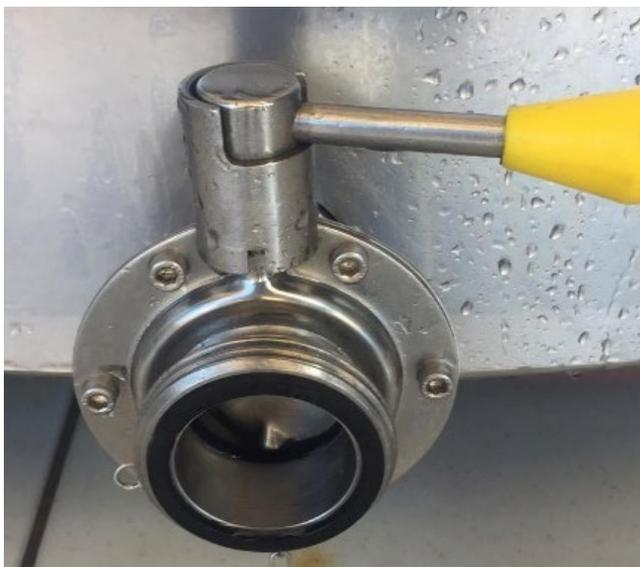
Da mesma forma que o equipamento de ordenha, o tanque de expansão pode ser local de acúmulo de resíduos de leite, sendo a sua limpeza feita pelo manualmente ou por circulação (CIP).
